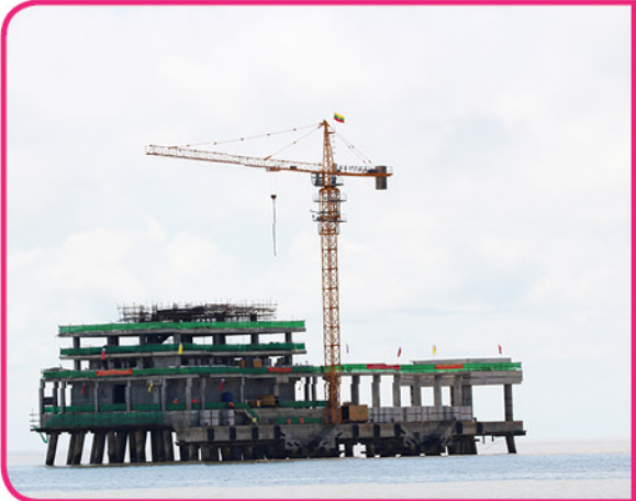
Offshore Fixed Pilot Station တည်ဆောက်ရေးလုပ်ငန်းသို့ သွားရောက်ကြည့်ရှု
